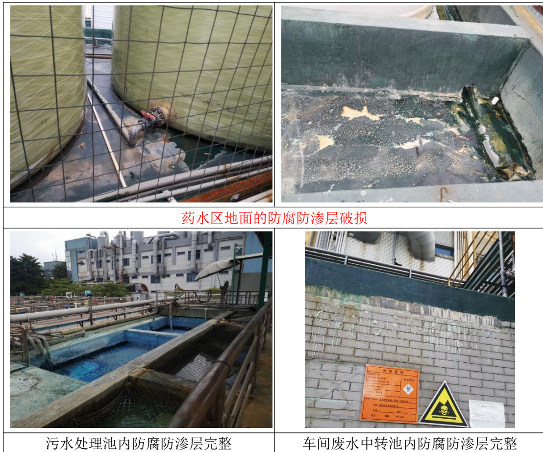
图 4.1-1 液体储存区现场排查情况
