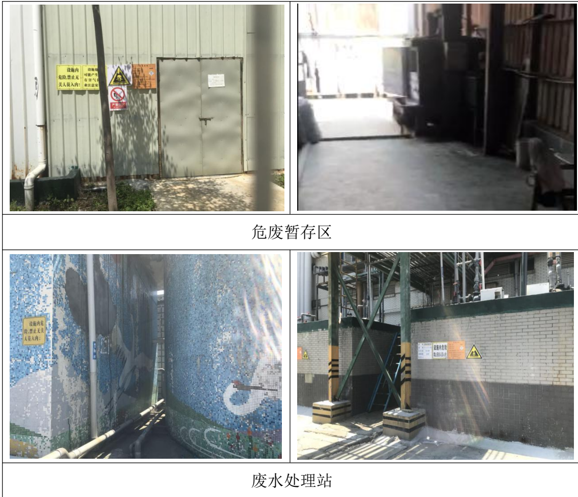
图 2-1 现场踏勘照片
